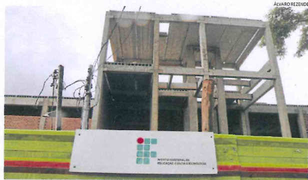
Campo Grande. Obra do prédio na Capital ainda está pela metade e não foi definido mês para conclusão
