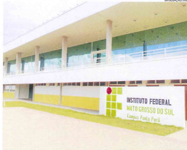
Ponta Porã. Campus da cidade fronteira (foto) e prédio de Aquidauana estarão prontos até fim do mês
