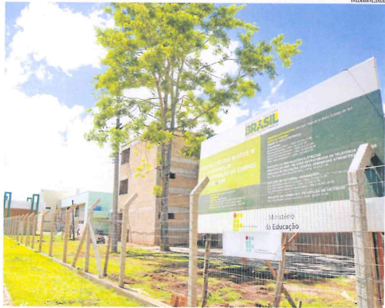
Bairro Santo Antônio. Prédio que abrigará as salas do Instituto Federal de Mato Grosso do Sul está em obras há quase quatro anos
