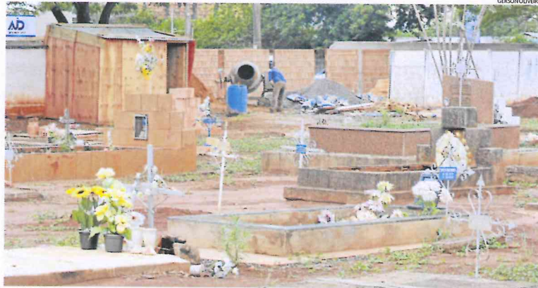
Medida emergencial. A superlotação dos cemitérios levou a Prefeitura de Campo Grande a ampliar o Cemitério Santo Amaro
